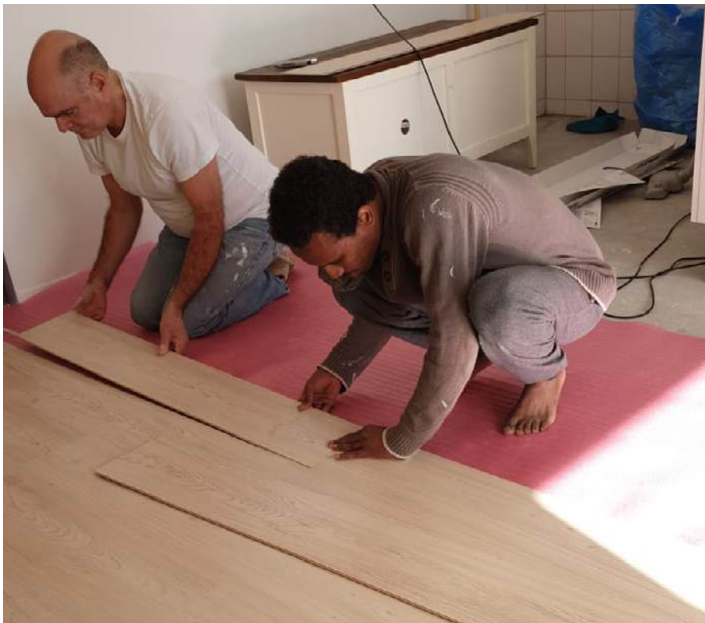
David en Abdalla leggen de vloer in de nieuwe woning van Abdalla.
